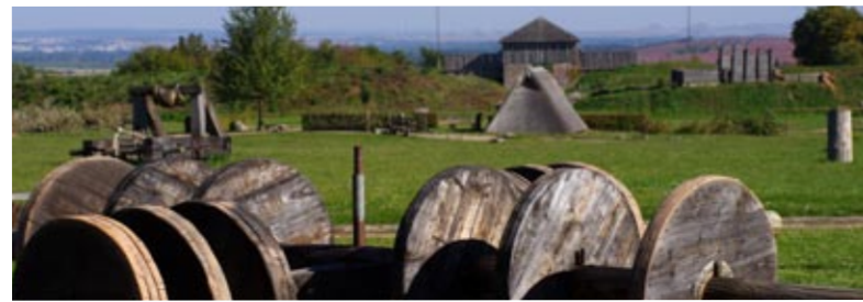
Obere Vorburg der rekonstruierten Pfalz Tilleda
