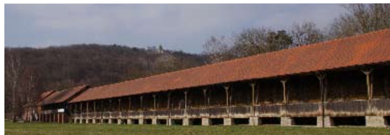
Gradieranlage in Bad Sulza
